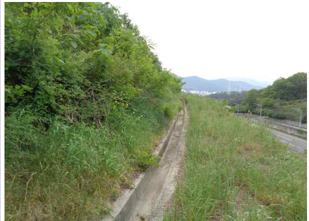
1소단 배수로 전경
