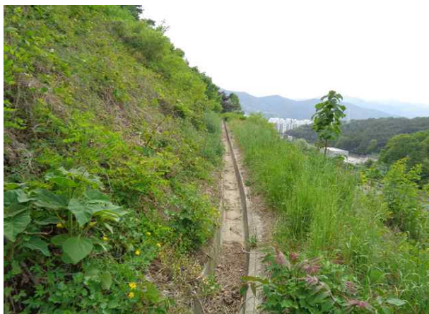
2소단 배수로 전경
